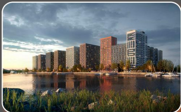
ЖК «Западный порт» Москва, ул. Заречная
